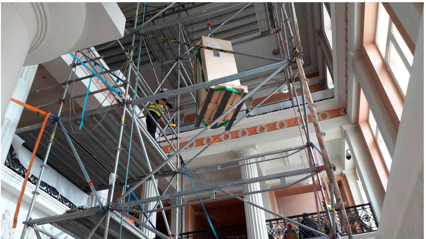
Vanerilaatikkoon suojattua veistosta nostetaan ylös yliopiston päärakennuksen vanhan puolen vestibyylin kerroksiin. Kuva: Anna Luhtala / Helsingin yliopistomuseo
