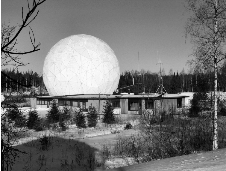
Kuva 1.19: Metsähovin 14 metrin radioteleskooppi. Teleskoopilla tehdään myös geodeettisia VLBI-havaintoja. (Kuva: M. Poutanen)
